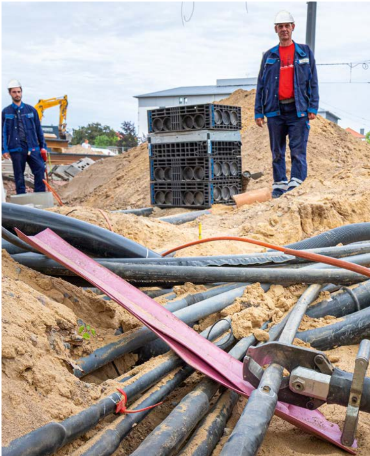
Mit der Fernbedienung wird die Schadstelle entfernt.
