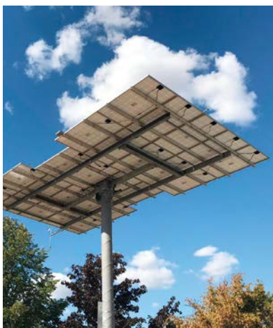
7,32 Kilowatt peak (kWp) schafft die neue Photovoltaikanlage für die Selbstversorgung der CTHS.
