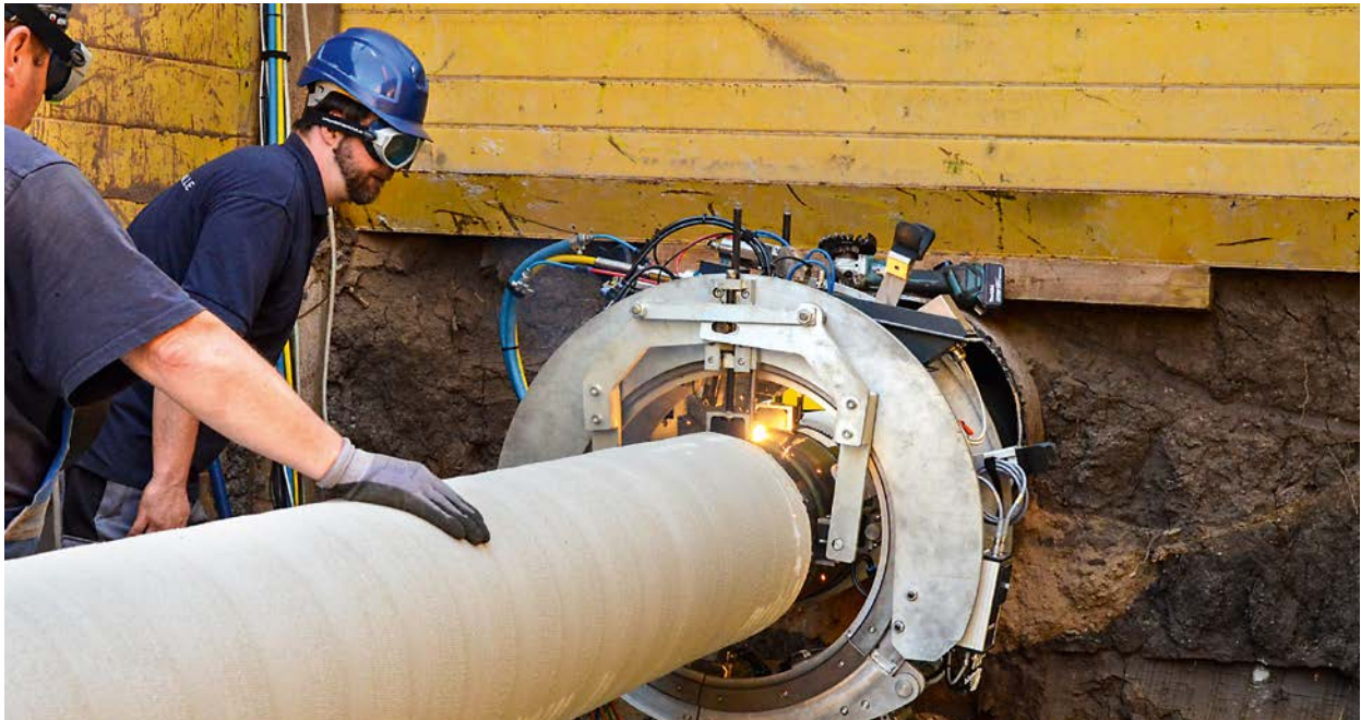
Einsatz an der Magdeburger Chaussee – Experten der Schweißtechnischen Lehr- und Versuchsanstalt Halle GmbH (SLV) setzen das orbitale Laserschweißverfahren erstmals in der Praxis ein.
