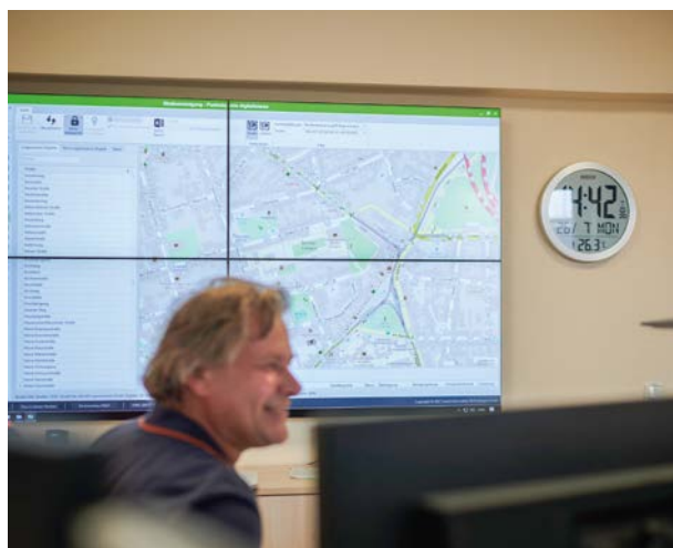
Herzstück des digitalen Leitstandes ist eine Monitorwand mit rund 232 Zentimetern Bildschirmdiagonale.
